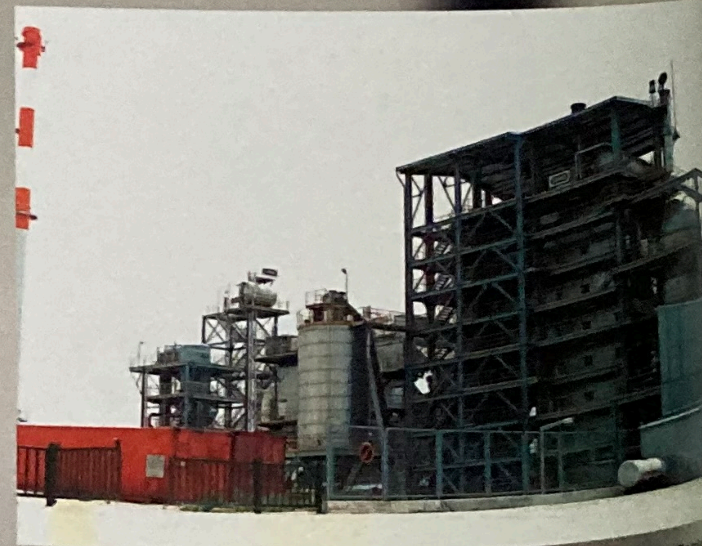
İzmit-Tehlikeli Atık İmha ve Depolama Tesisi
